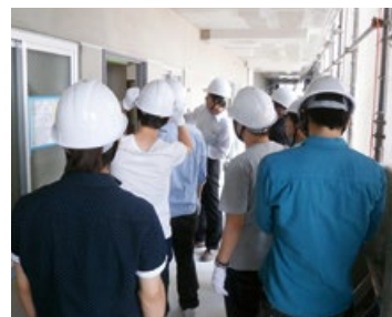
現場内見学の様子
