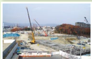
場内の土砂仮置き
