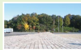
当時の敷設状況
