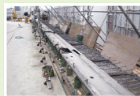
作業所内に設置したPCa工場
