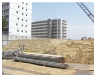
敷地内の土砂仮置き
