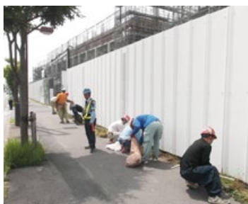
現場周辺の清掃・草刈り
