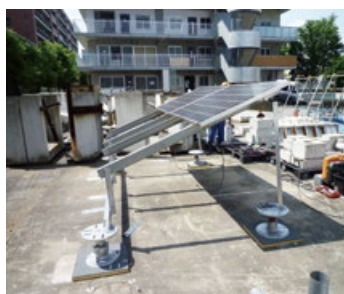
防水更新対応フレーム（防水改修時）
