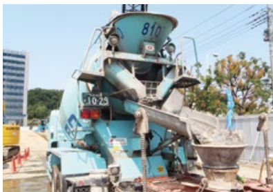
杭コンクリート打設
